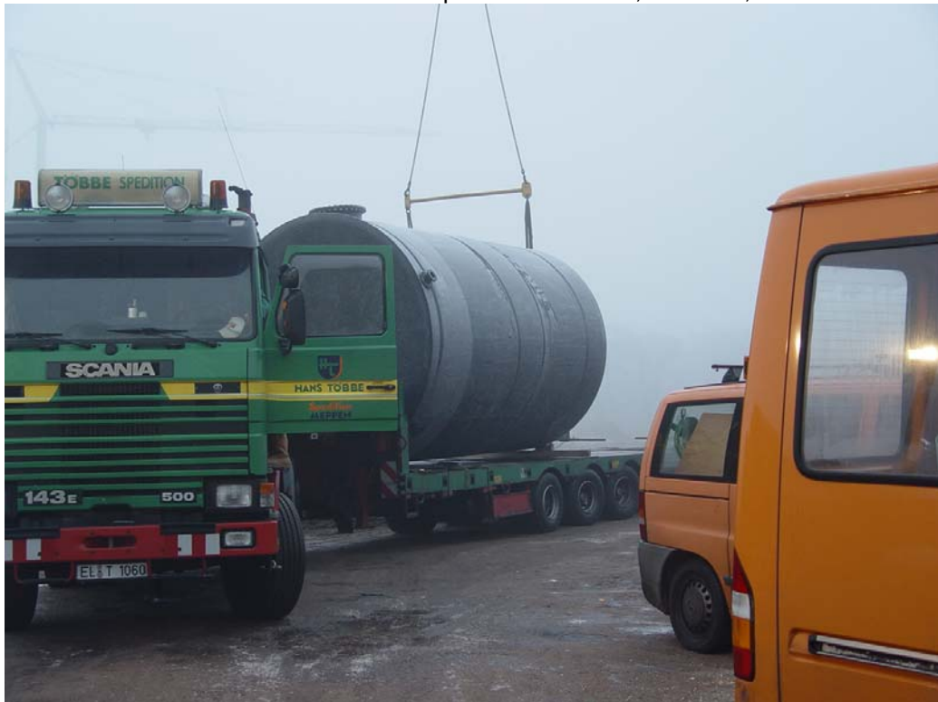
PE-HD-Prozess- und Brauchwasserspeicher V = 35 m 3 , DN 3000, H = 5500 mm
